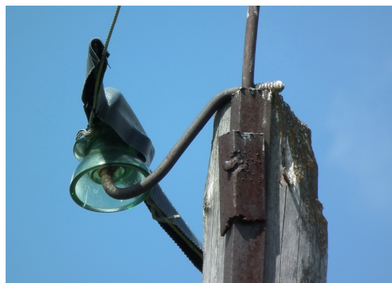
Рис. 6. Деформированное ПЗУ на ВЛЭП с деревянными опорами
