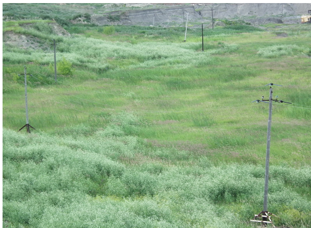
Рис. 1. ПЗУ на ВЛЭП с деревянными опорами в окрестностях с. Валы
