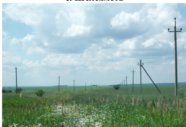
Рис. 4. Параллельные ВЛЭП (левая без ПЗУ, правая с ПЗУ) между Березовым Солонцом и Малой Рязанью
