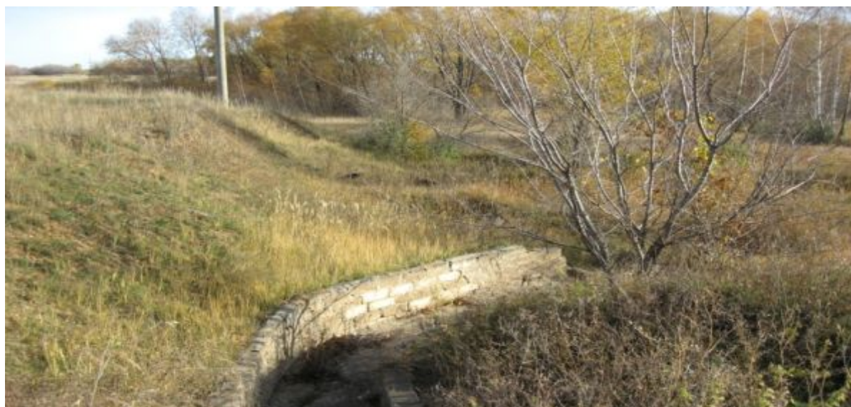
Рис. 6. Бетонная основа в месте окончания канала находится вершина оврага
