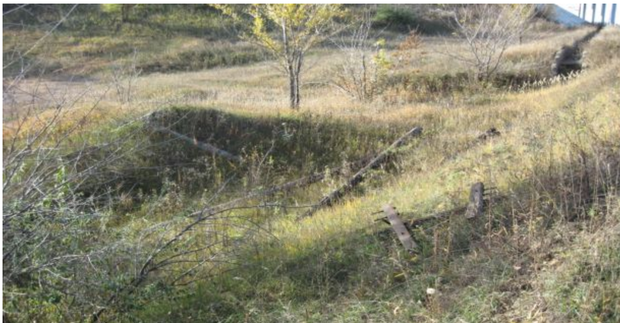
Рис. 7. Конус выноса оврага в полосе отвода
