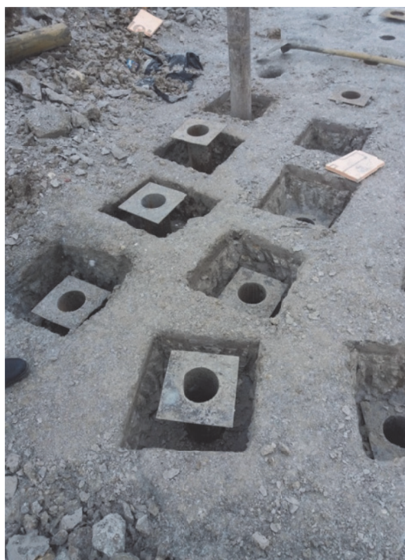
Рис. 7. Скважины, подготовленные для высоконапорной закачки (фрагмент); шаг 1,0 м; глубина – 20,0 м
