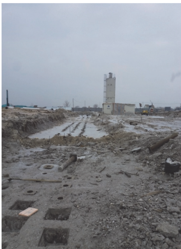
Рис. 6. Опытный участок; скважины, подготовленные для высоконапорной закачки рабочего раствора флокулянта
