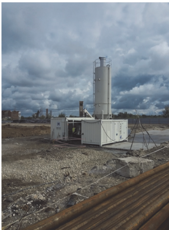
Рис. 4. Высоконапорная насосная станция
